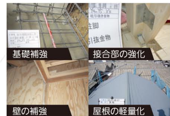
耐震補強工事の様子
