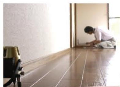
床の傾き・外壁のヒビ 割れなどの計測
